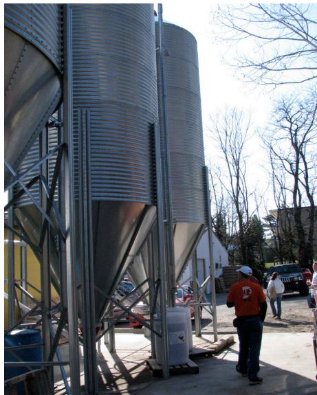
New grain silos.
